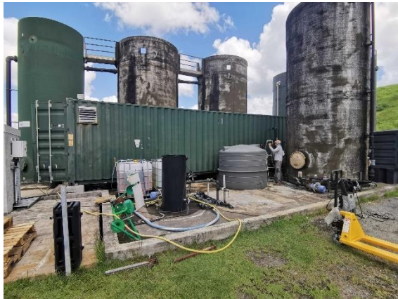
Installation cuve eau potable 4.5 m 3 sur dalle BRM
