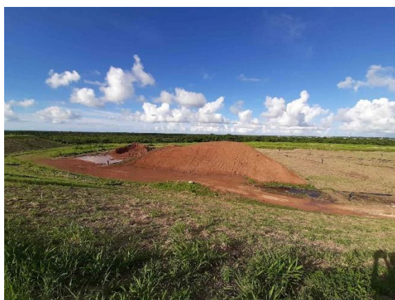
Stock de déblais argileux sur casier Nord-Est historique
