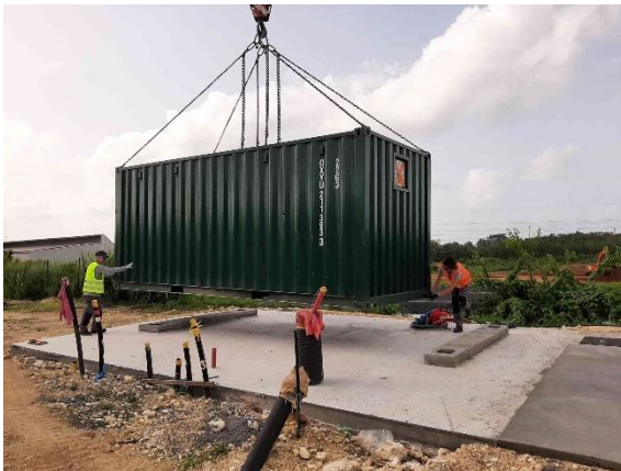
(18/07) Mise en place container process du dispositif de réinjection des lixiviats
