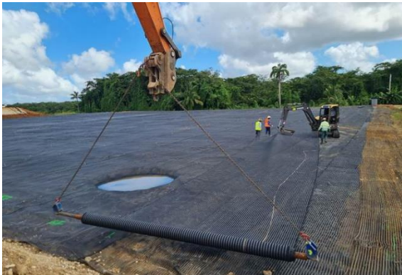
Pose géogrille en fond de subdivision
