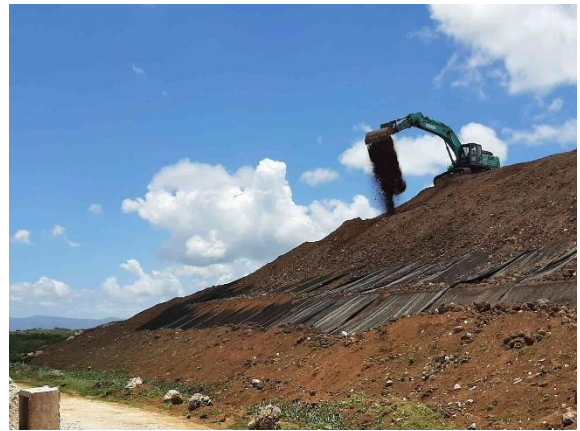
(19/05) Végétalisation couverture sur talus Sud-Ouest du casier Nord-Ouest
