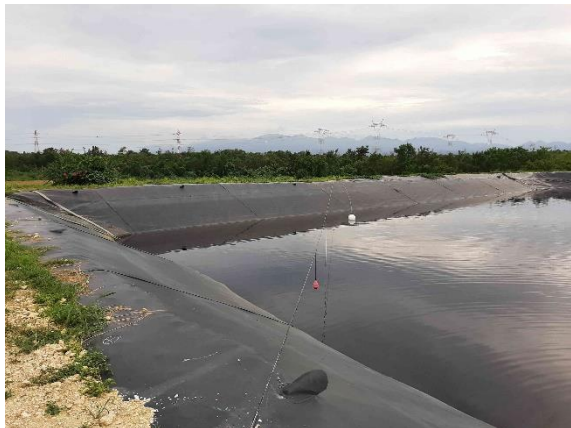
Bassin principal lixiviats contenant des lixiviats bruts
