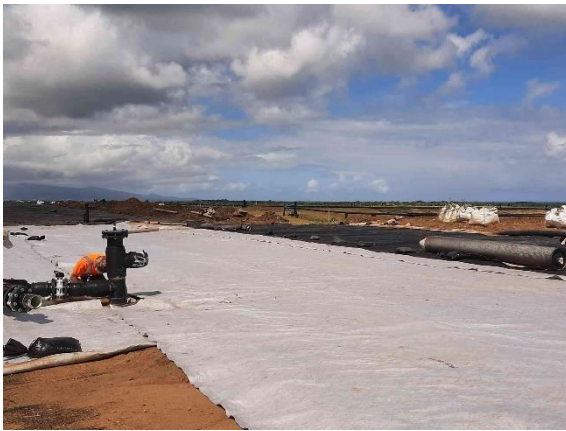
(24/02) Couverture par géosynthétiques
