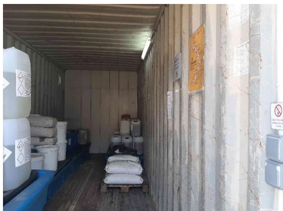
Container de stockage produits chimiques
