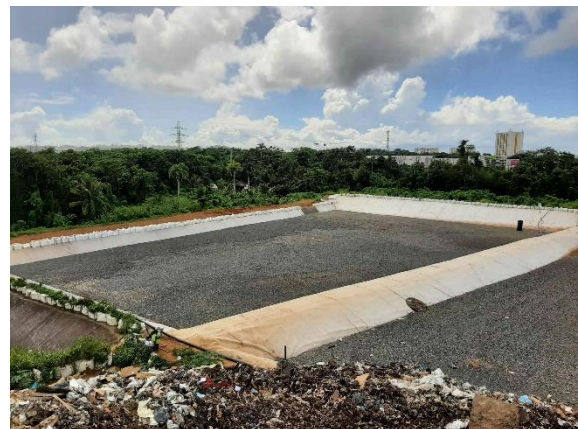
Couche drainante en fond de subdivision S4
