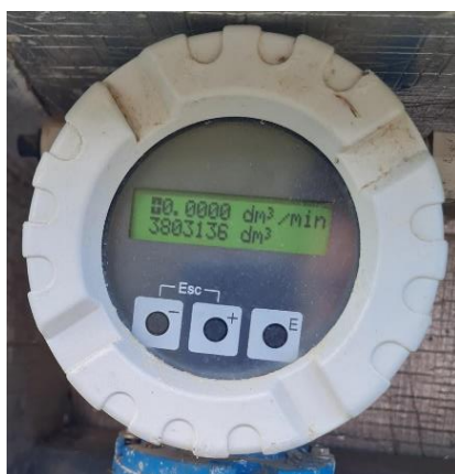
(29/12) Relevé débitmètre lixiviats D1 comptant pour le bilan du mois de décembre 2023
