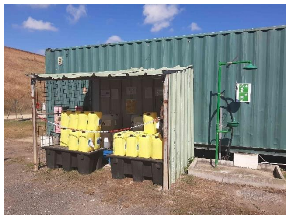
Abri extérieur de stockage produits chimiques
