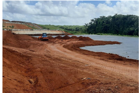
Mise en œuvre remblais Barrière de Sécurité Passive
