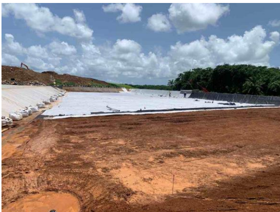
Pose dispositif d'étanchéité par géosynthétique
