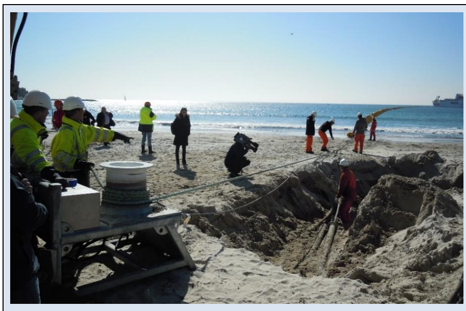
Figure 18 : Opération de tirage du câble avec un cabestan hydraulique
