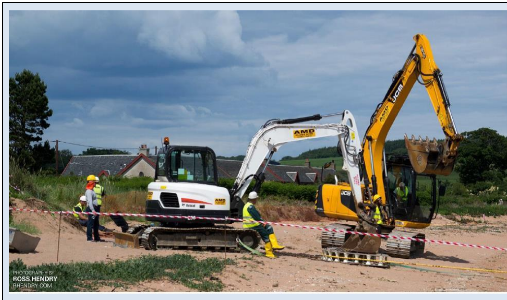
Figure 17 : opération de tirage de câble avec deux pelleteuses et un quadrant
