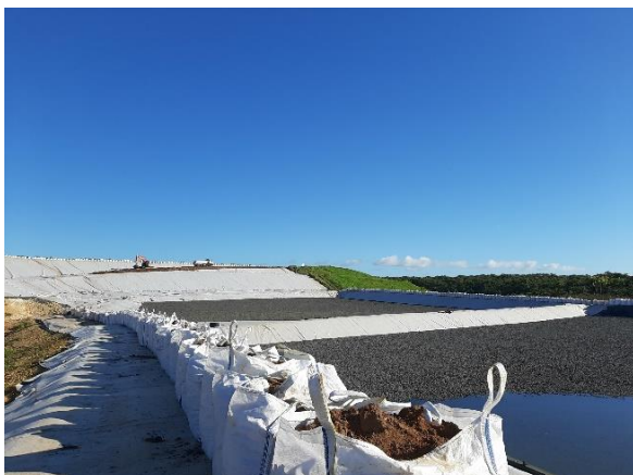
Subdivisions en attente d'exploitation avec couche drainante en fond
