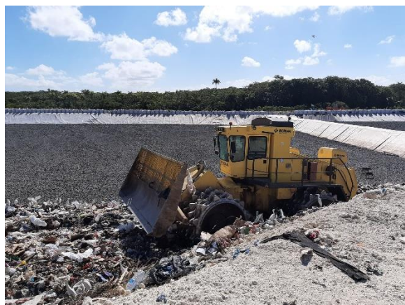
Compactage dans une subdivision en cours d'exploitation
