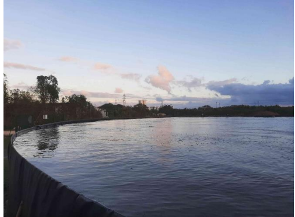
Silo de stockage de lixiviats traités répondant aux besoins d'alimentation de la TAR
