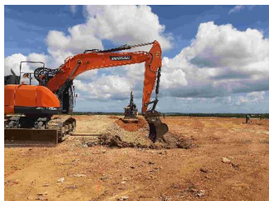
Engin de chantier
