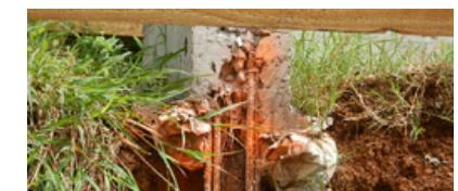
Les poteaux et les chaînages ne doivent pas être utilisés comme passage pour les canalisations et les gaines.
