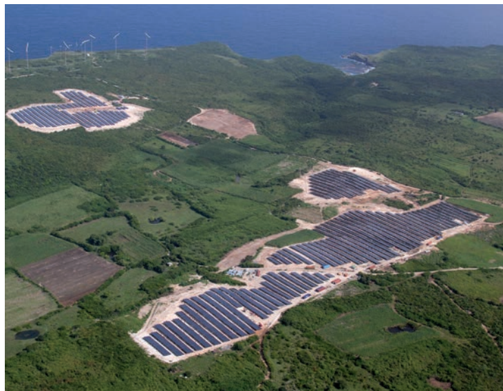
Centrale photovoltaïque en Guadeloupe
