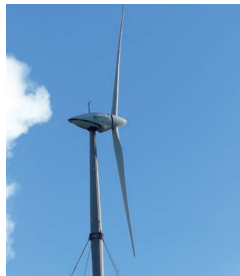
Éolienne à Désirade
