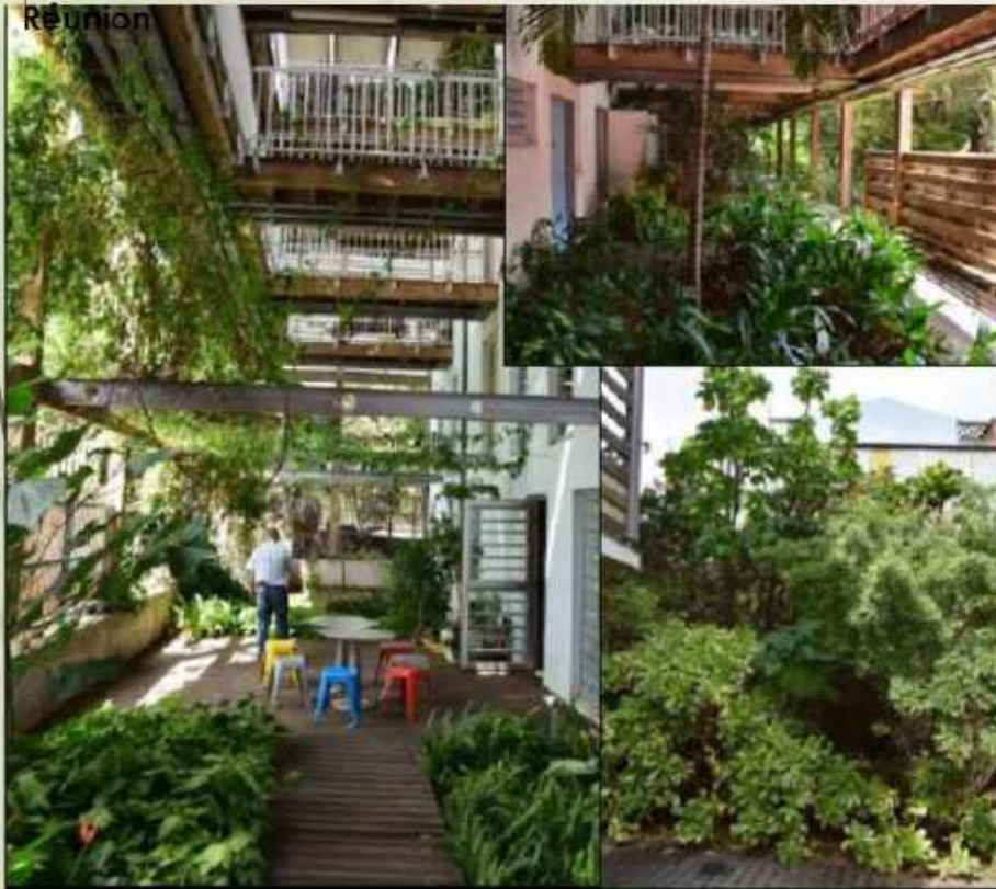
Patio végétalisé de bâtiment bioclimatique à la Réunion
