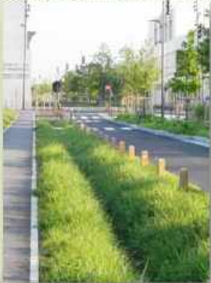
Noue végétalisée en métropole
